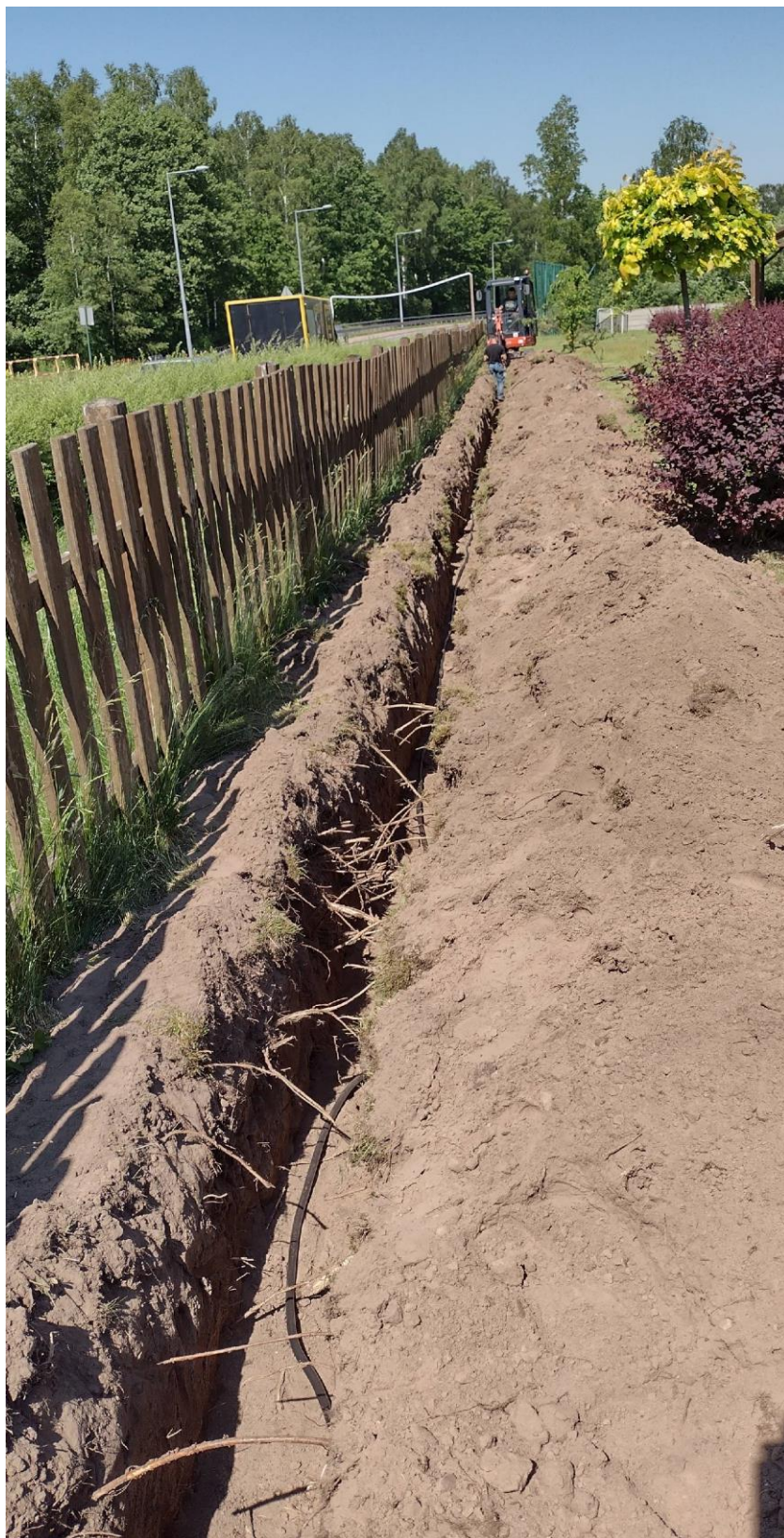
1) W 2021 roku wykonano wymianę kabla ziemnego i podłączono nowy kabel na placu zabaw przy ul. Kieleckiej w Zagnańsku – koszt realizacji – 2 792,00 zł brutto.
