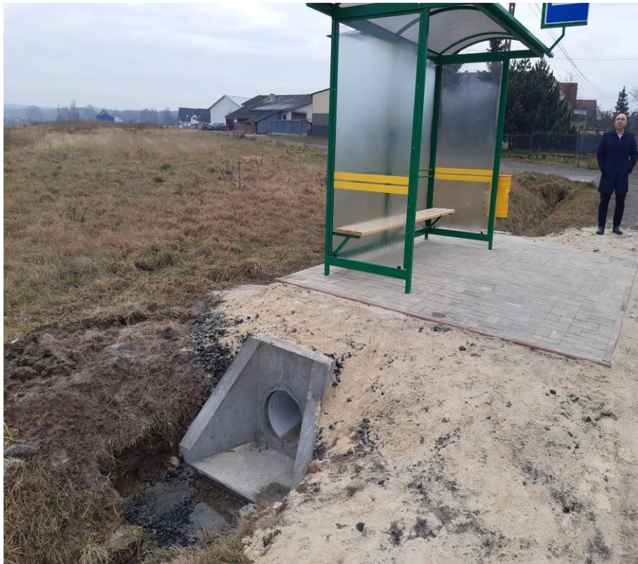
3. Nowa wiata przystankowa w msc Gruszka w pobliżu drogi ul. Widokowa
