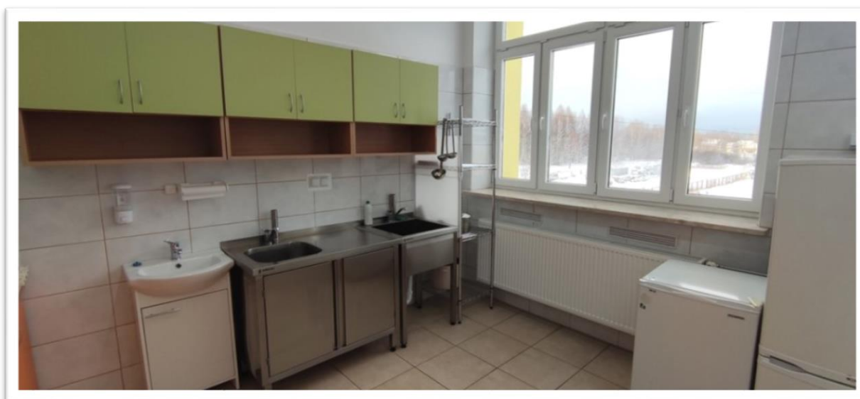
Wydzielenie zmywalni naczyń stołowych w pomieszczeniu kuchennym w SP w Kajetanowie
