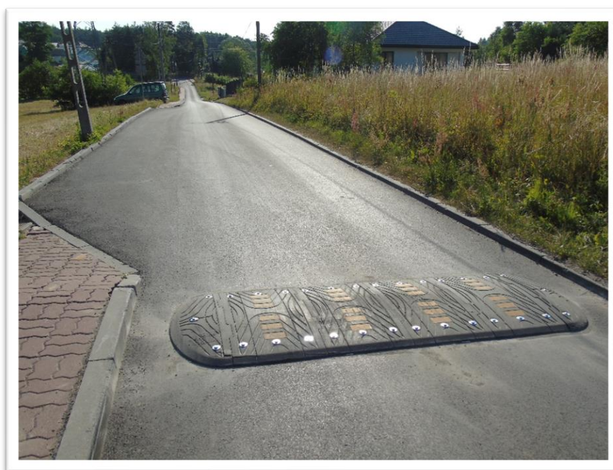
❖ Zagnańsk ul. Piaskowa ułożenie nowego dywanika asfaltowego i progu zwalniającego
