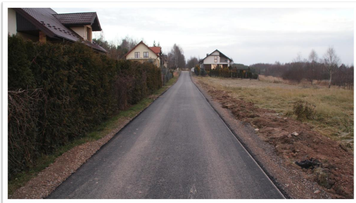
❖ Gruszka, ul. Uroczą – wykonanie nakładki asfaltowej wraz z utwardzeniem pobocza na długości 186 m. Wartość zadania wyniosła 52 457,73 zł
