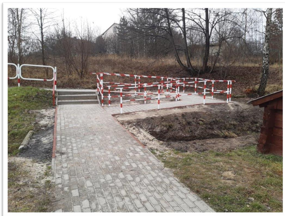
❖ Kajetanów wykonanie rampy dla wózków inwalidzkich
