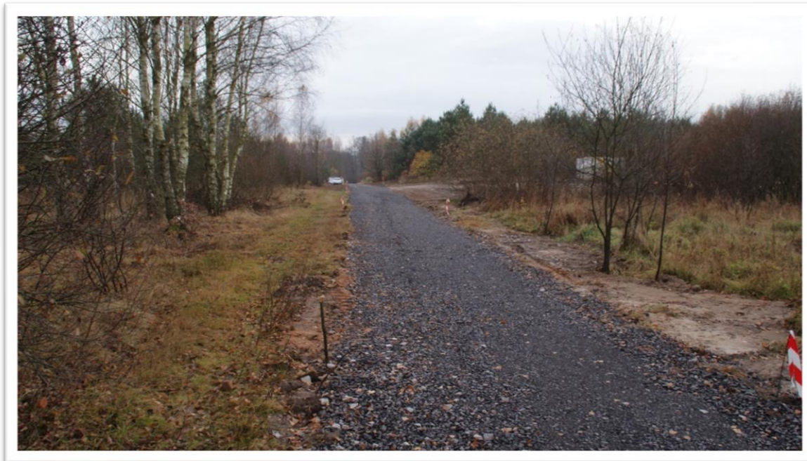
❖ Utwardzenie drogi na ul. Milej w Kołomani, prace wykonano w ramach funduszu sołeckiego za kwotę 11 413,81 zł i programu modernizacji dróg dojazdowych do gruntów rolnych za kwotę 20 7879,94
